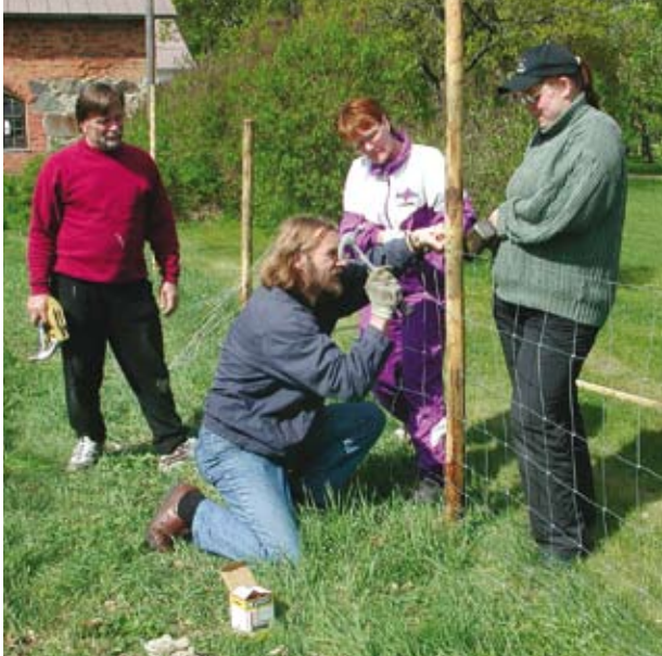
Lammasverkko on pitkäaikainen aitamateriaali. Tolppien tulee olla tukevia ja valmistettu kestävästä materiaalista.
