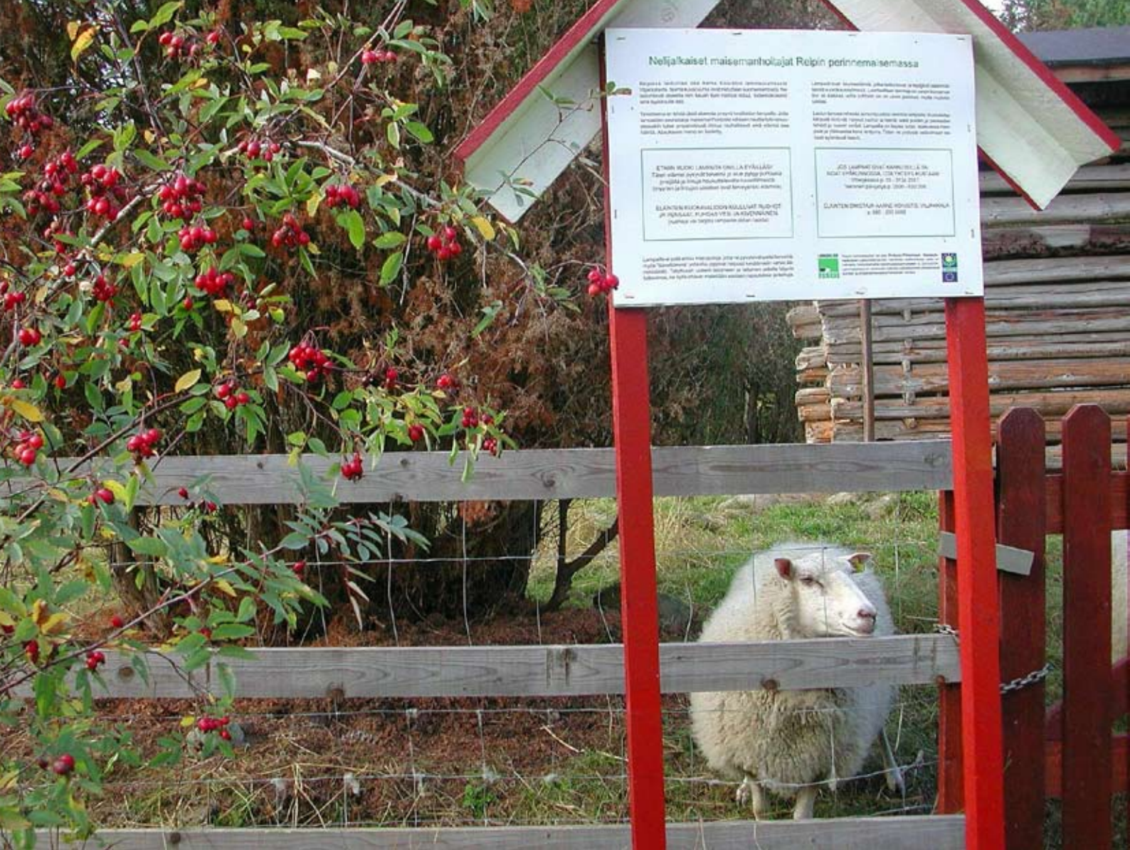
Virkistyskohteissa ovat tärkeitä sekä tiedottaminen että toimivat rakenteet. Laidoilla vahvistettu lammasverkko on kestävä aita, joka kestää kevyttä nojailemistakin.
