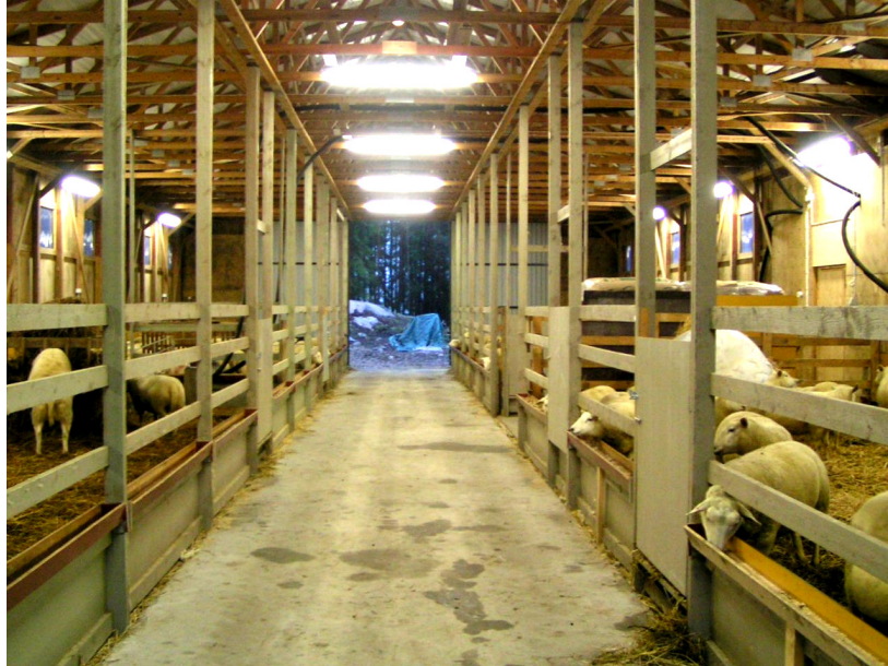
KUVA 17 Hallin karsinarakenteet ovat purettavissa (Löytönen 2007).
