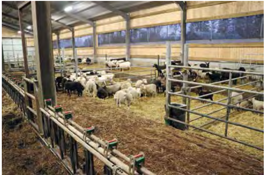
Tuiskulan tilalla lampolan pohja on valettu eri tasoihin.
