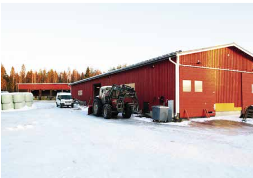
Kuvassa etualalla vuonna 2016 rakennettu kylmälampola, takana vuonna 2018 rakennettu kolmiseinäinen pihatto. Rakennukset on tehty kustannuksia silmällä pitäen ja muunneltaviksi, jos lammastuotannosta jonain päivänä luovutaan.
