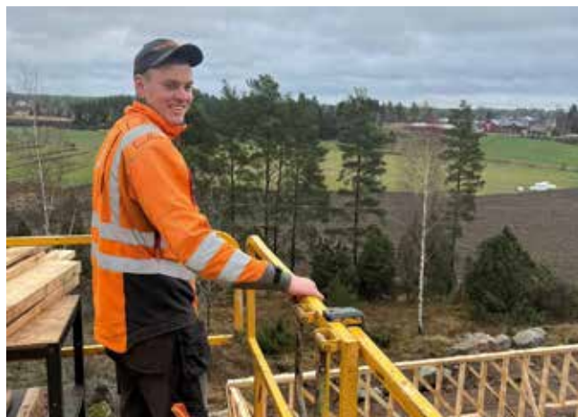
Isäntä rakennustyömaalla nosturissa noin 15 metrin korkeudessa, ja vielä hymyilyttää.
