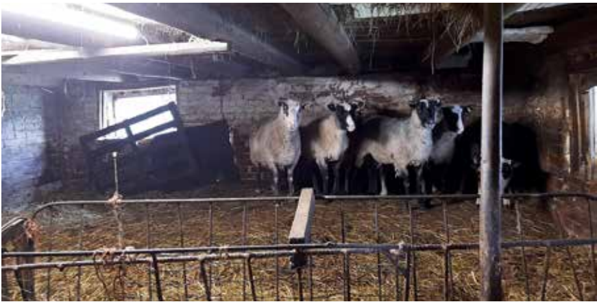
Lampaiden pitopaikan lantapatteri oli noussut yli metrin korkeuteen, eläimillä ei ollut käytössään kuivaa ja puhdasta makuupaikkaa ja pitopaikan ilmanlaatu oli heikko. Osa lampolan seinästä oli romahtanut. Lampaille ei ollut tarjolla rehua tai vettä.
